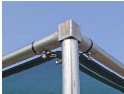
Tourner quelques vis de blocage pour assembler
